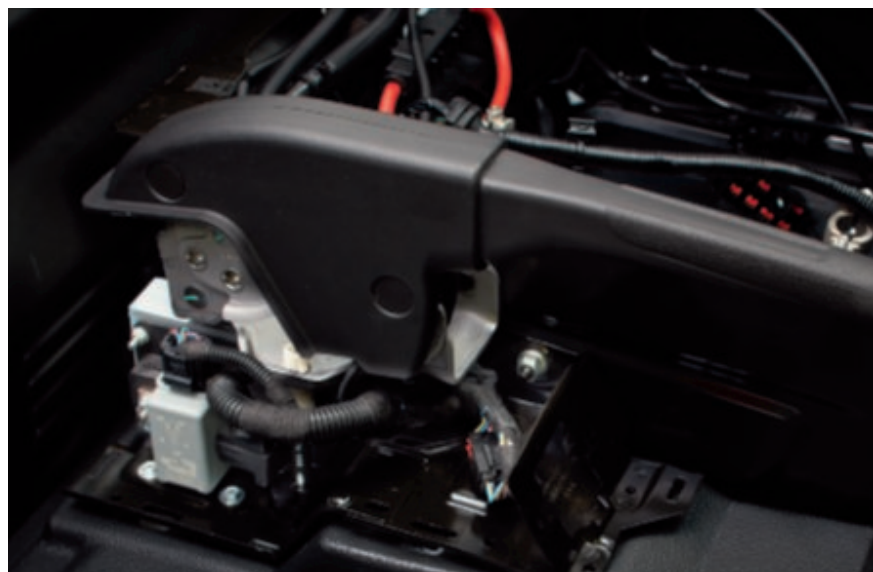
Podpěťová ochrana baterie
